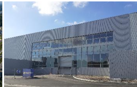
Martignas - Jonctionnement bâtiments 1 et 2
