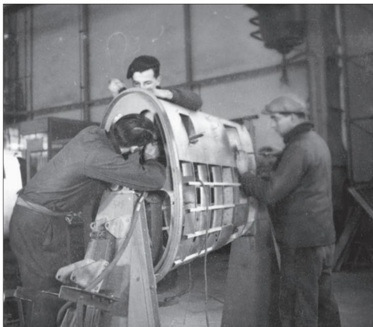
Fabrication du tronçon arrière du fuselage à Châteauroux-Déols en 1940.
